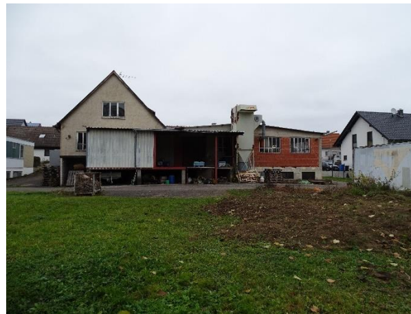
Abb. 4: Südansicht Werksgebäude Hindenburgstraße 51
